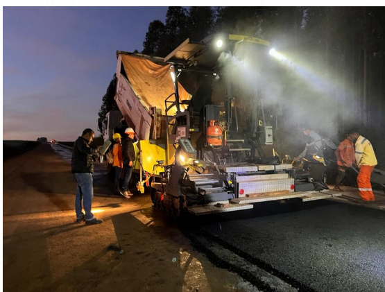
Pavimentação do acesso ao Museu Moisés Bertoni. Foto MOPC publicada pela Agência IP em 01 agosto 2023. Registro da execução do asfalto no acesso a Bertoni.
